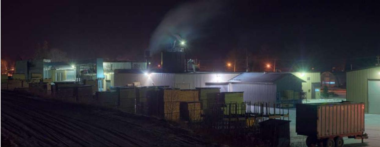
L'industrie éclaire maintenant ses bâtiments avec des luminaires qui offrent un meilleur contrôle du flux lumineux et qui utilisent des ampoules au sodium à haute pression de 70 W. Cette conversion a permis de réduire la consommation énergétique de 32 000 kWh par an.
