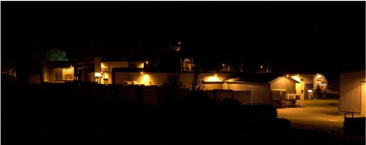
Cette scierie utilisait des sentinelles au mercure 400 watts pour assurer l'éclairage de ses aires de manutention. Les défauts de l'éclairage sautent littéralement aux yeux.
