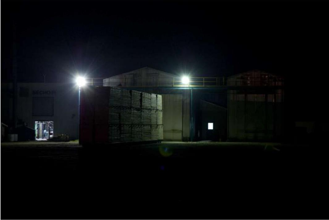
Les nouveaux luminaires éclairent maintenant la scierie avec des ampoules à haute pression de 150 W. L'entreprise y a gagné en économie d'énergie et dans la sécurité des lieux, les surfaces sont bien mieux éclairées !
